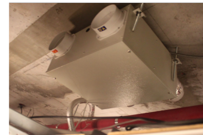
[ 천장 타공 후 매립 설치 ]
